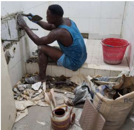
Reparatur im Gila-Hospital.
