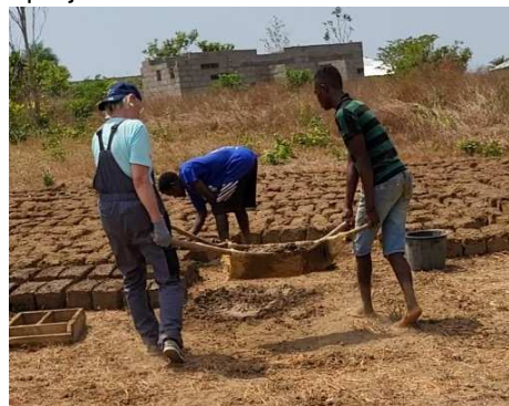
1. Amie's Baustelle, 4.000 Sandblocks müssen von Hand hergestellt und gewendet werden. 2.+3.: Sandmörtel schleppen, Sandblocks in Holzkästen formen. Der Rohbau muss bis zur Regenzeit hochgezogen werden, ein Dach bekommen und von außen einen Zementputz erhalten, ansonsten lösen sich die Sandblocks „in Wohlgefallen“ auf.
