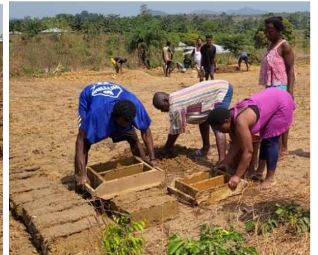
1. Amie's Baustelle, 4.000 Sandblocks müssen von Hand hergestellt und gewendet werden. 2.+3.: Sandmörtel schleppen, Sandblocks in Holzkästen formen. Der Rohbau muss bis zur Regenzeit hochgezogen werden, ein Dach bekommen und von außen einen Zementputz erhalten, ansonsten lösen sich die Sandblocks „in Wohlgefallen“ auf.
