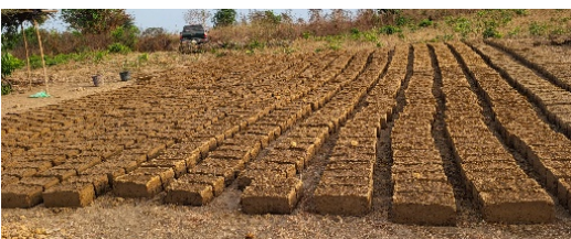
1. Amie's Baustelle, 4.000 Sandblocks müssen von Hand hergestellt und gewendet werden. 2.+3.: Sandmörtel schleppen, Sandblocks in Holzkästen formen. Der Rohbau muss bis zur Regenzeit hochgezogen werden, ein Dach bekommen und von außen einen Zementputz erhalten, ansonsten lösen sich die Sandblocks „in Wohlgefallen“ auf.
