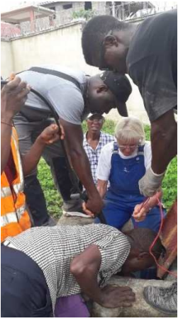
Das Bohrloch, 59 m tief.
